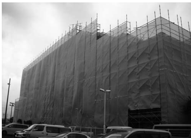
作業中は従来通りシートで養生しながら作業を行う
